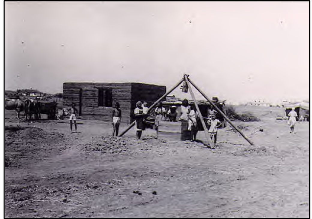
Hausbau aus Lehm und Brunnengraben
