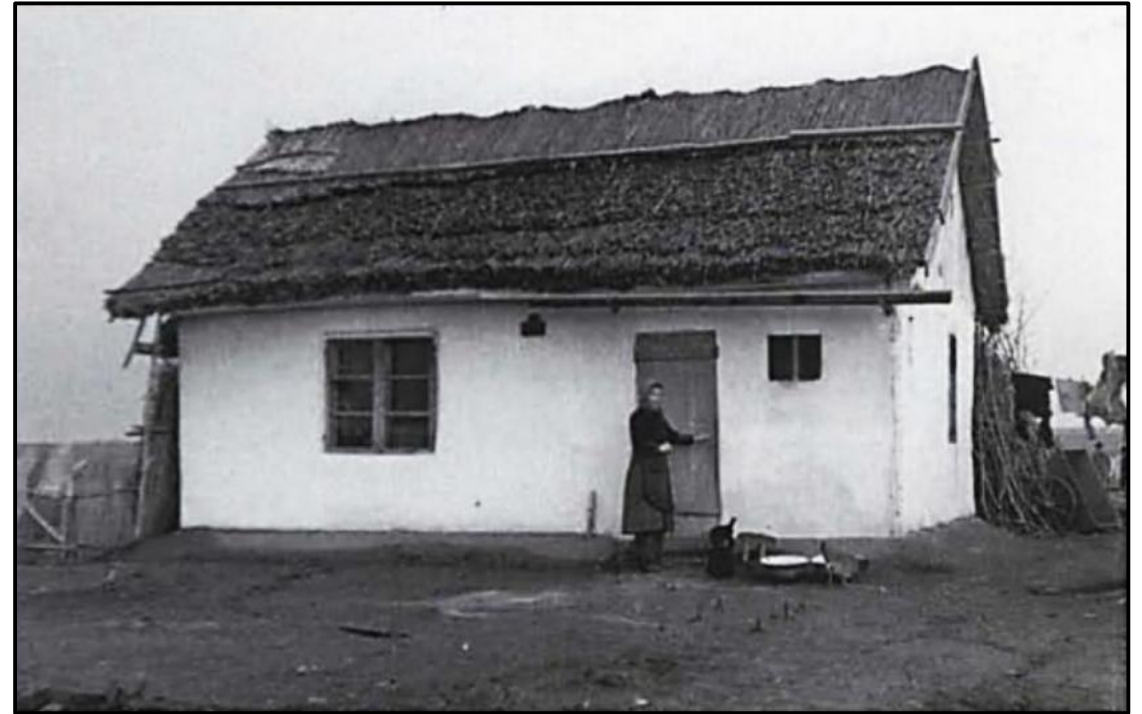
Das Dach wird mit Schilf gedeckt
